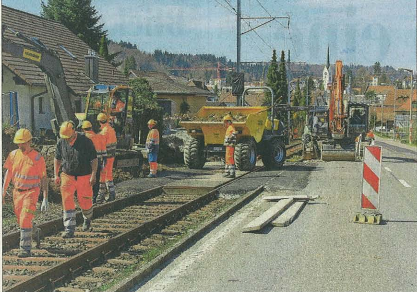
Baustelle Seon: Nicht ungefährlich neben 13 000 Fahrzeugen pro Tag.
